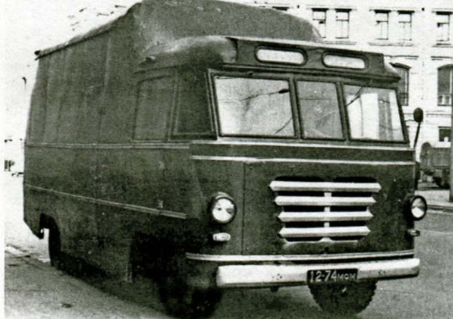
КАГ-3 второй серии в весьма редком исполнении грузового фургона с наращенной крышей. Москва, кон. 1960-х гг.
